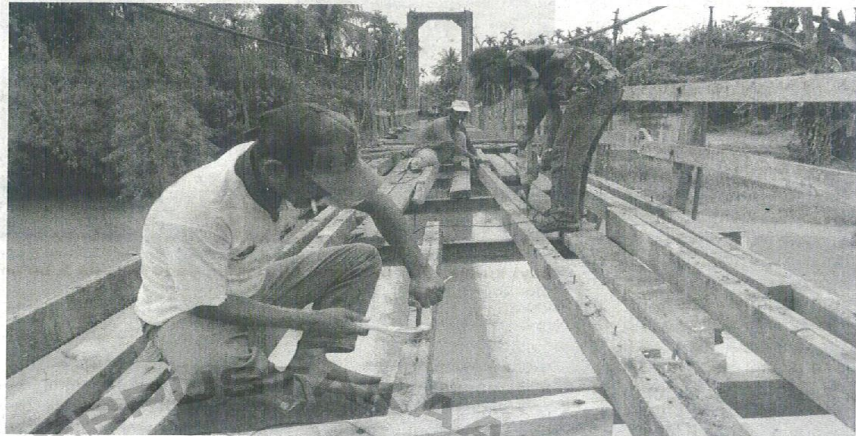
Warga memperbaiki lantai jembatan gantung di Desa Rayeuk Pange, Kecamatan Pirak Timu, Aceh Utara, Provinsi Aceh, belum lama ini. Program Dana Desa cukup membantu penyediaan infrastruktur dasar yang dibutuhkan masyarakat perdesaan.
