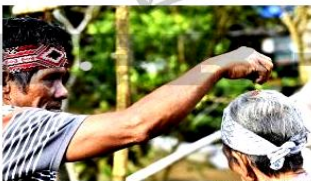
Warga suku Dayak Taman Meragan bergotong royong membangun rumah salah satu warga di Kampung Sangke, Desa Meragan, Kecamatan Nanga Taman, Kabupaten Sekadau, Kalimantan Barat, Rabu (4/3/2026). Pembangunan rumah adat yang merupakan bagian integral dan tak terpisahkan dari masyarakat adat sebagai unsur inti, penggerak utama, sekaligus penjaga keberlanjutan tradisi dan sumber daya alam komunitas.
