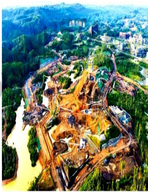
Pembangunan di kawasan yudikatif Ibu Kota Nusantara (IKN) di Kalimantan Timur, Minggu (17/5/2026). Pemerintah terus menuntaskan pembangunan di IKN.
